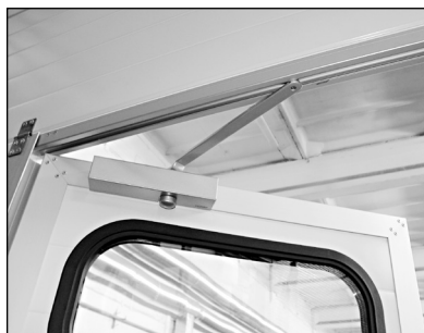
Рис. 44а. Установка доводчика. Калитка открыта
